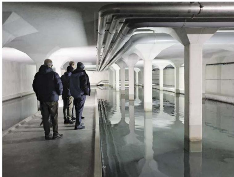
14 unterirdische Langsamfilterbecken, die verschiedene Kiesgrössen enthalten, sind für den finalen Wasserreinigungsprozess im Einsatz. (Bild: cef)
